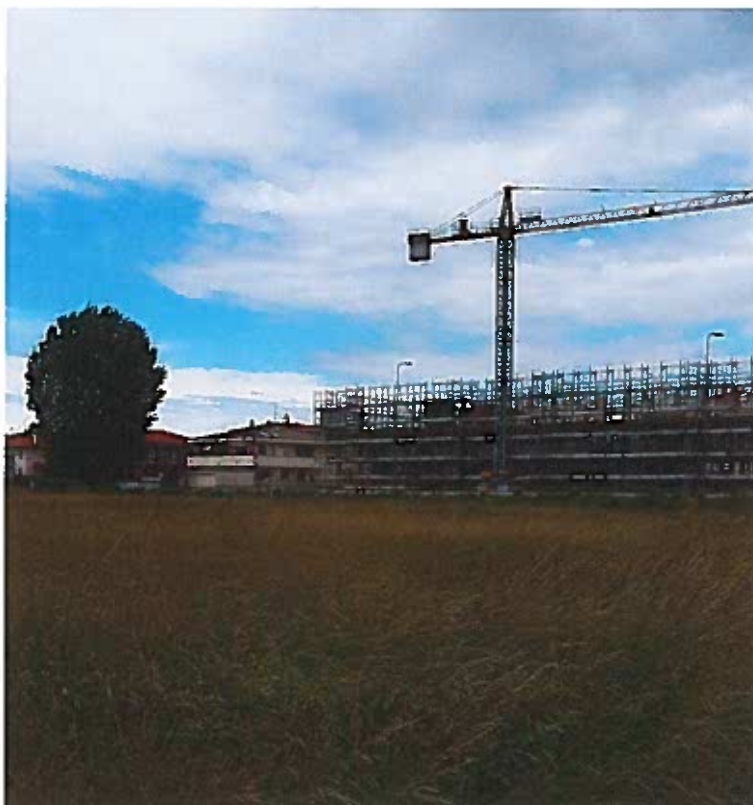
Foto n° 13 – Vista verso gli edifici in costruzione su via I Maggio
